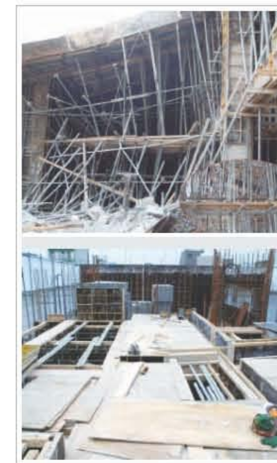
〈합판 거푸집 설치현장〉
